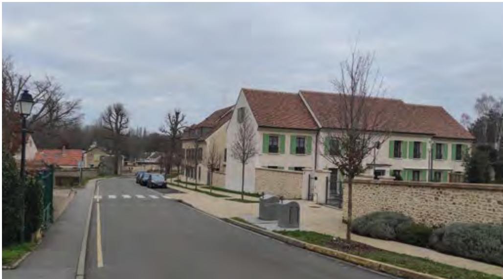
Développements urbains à Montfort Lamaury (78) ©MRAe-Idf
