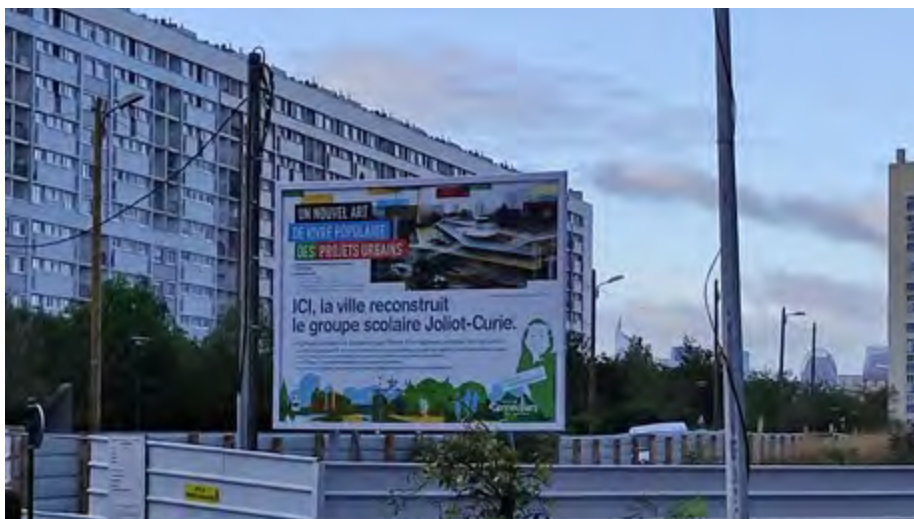
Opération de rénovation urbaine à Gennevilliers (92) © MRAe-IdF
