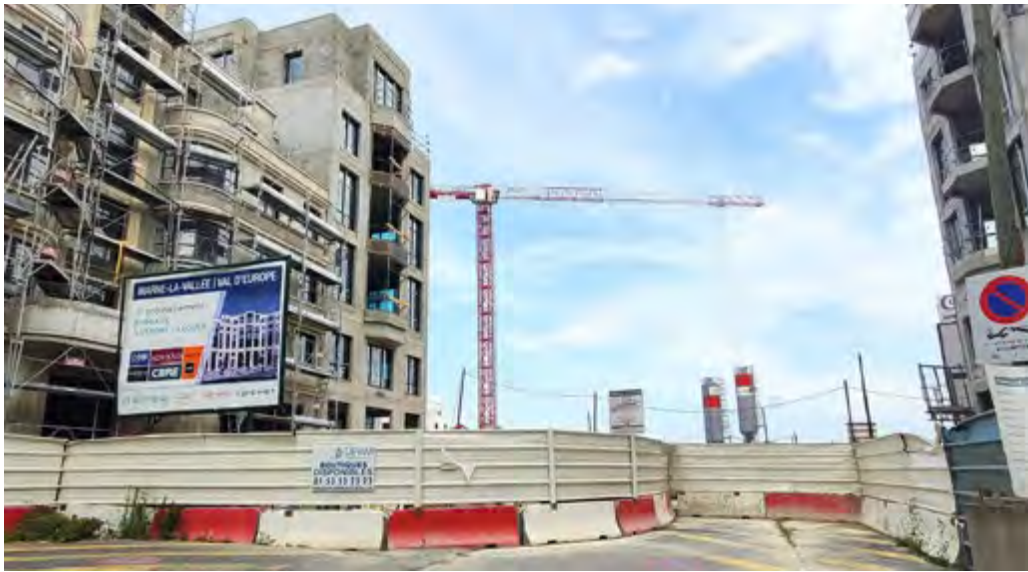
Construction d'un nouveau quartier à Val d'Europe agglomération (77) ©MRAe-IdF
