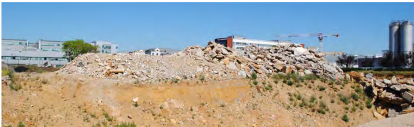
Terrassements en cours au Plessis-Robinson (92) © MRAe-IdF
