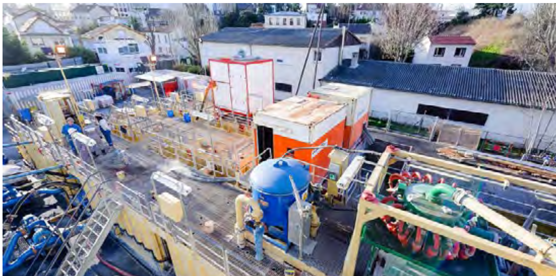
Projet géothermique à Arcueil et Gentilly (94), © Terra/MTE
